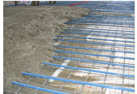
Ce treillis peut être mis en place sur les dalles isolantes KAN-therm Tacker ou sur les panneaux isolants standards EPS avec du film anti-humidité PE, fixé à la styromousse avec des goupilles plastiques.
