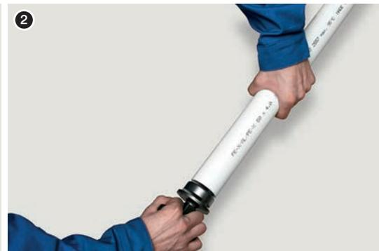
3. Placer le bout chanfreiné du tube dans le raccord. Vérifier par le trou de visite de la bague si le tube est bien inséré - celui-ci doit être visible par les trous.
