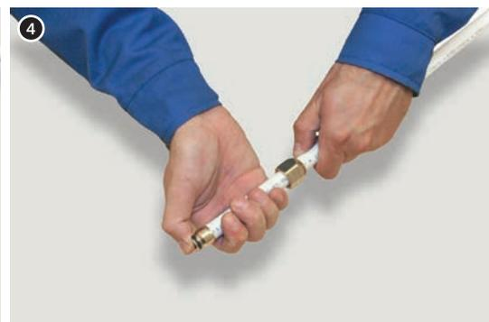
5. Insérer à fond le corps du raccord union (du manchon) avec le tube dans le raccord. Approcher la bague ouverte au raccord.
