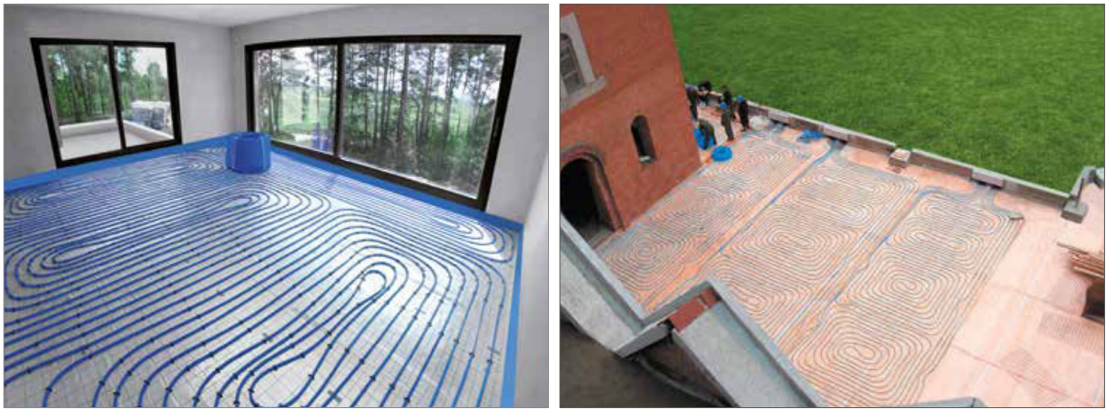
Plancher chauffage/rafraîchissement posé par procédé humide – les tubes chauffants sous chape
