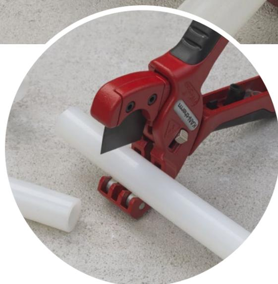
**01** Coupez le tube du système KAN-therm ultraLINE sélectionné perpendiculairement à l'axe à la longueur requise à l'aide du coupe-tube en plastique.
