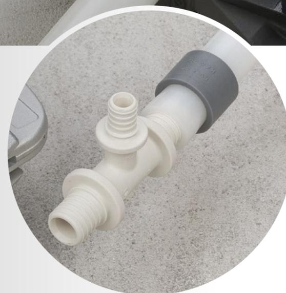
**03** Immédiatement (!) après l'évasement, enfoncez le raccord dans le tube jusqu'au dernier coude de l'embout du raccord.
